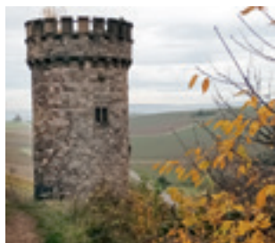
Neu-Bamberg Ajaxturm 2021 Foto: H. Kerutt
